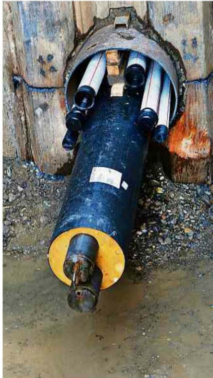
Das Rohr wurde mit einer anspruchsvollen Unterpressung verlegt. Bild: pd
