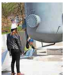
Der Oberbauleiter packt an.
