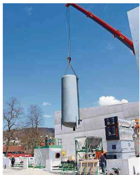
Der Wärmespeicher wird mit dem Kran an seinen Standort gehievt.
